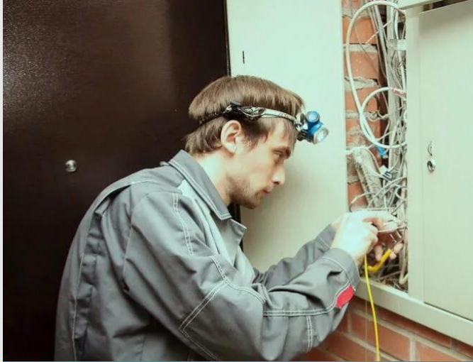
Монтажник систем связи
