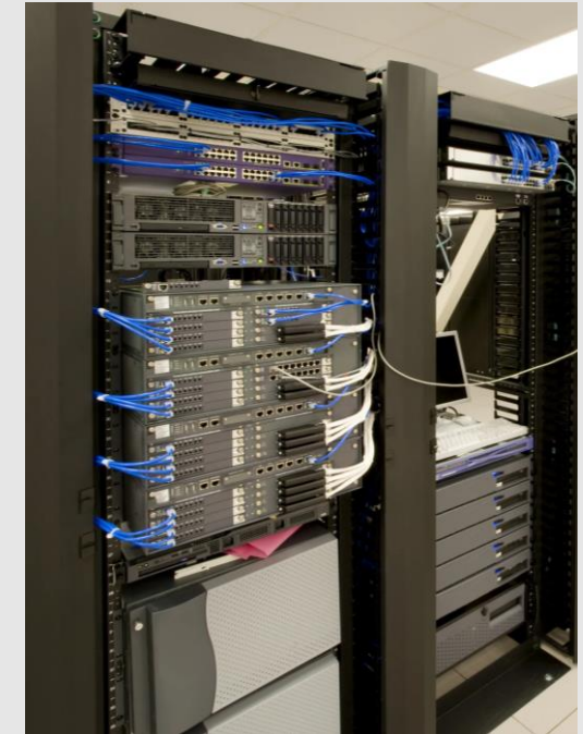
Установка ПО и драйверов на ПК и серверах
