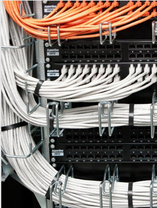
Монтаж локальных компьютерных сетей
